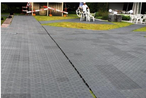
Bild 5: Richtig! Dehnungsfuge verhindert Aufbäumen des Bodensystems bei Wärmeausdehnung
