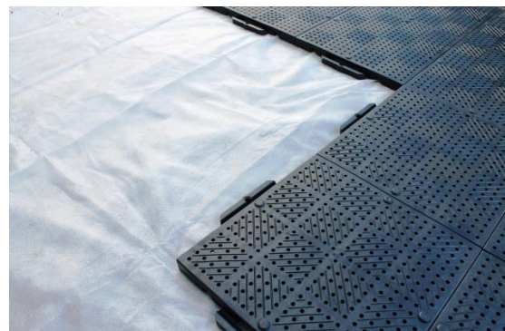
Bild 2: Verlegung auf Geovlies
